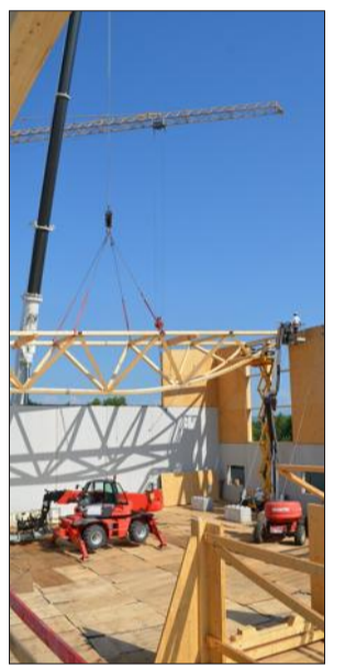
La pose des toblerones, une étape délicate. Photo Le DL/A.H.
